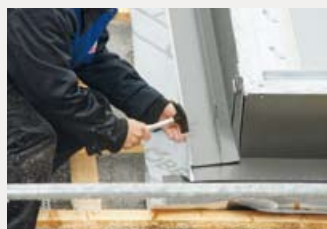
▲ Befestigung eines Eindeckrahmenblechs mit Wasserablauf-rinne am Stapelspeicher
