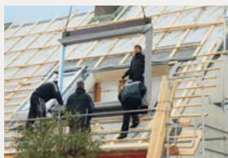
▲ Der große Blendrahmen wird mit Hilfe des Autokrans in die Einbauöffnung bugsiert
