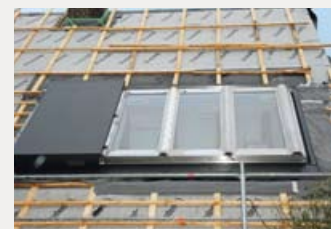
▲ Nach rund vier Stunden war das Panorama-Fenster inklusive Eindeckrahmen eingebaut
